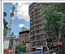
● Il restauro in corso a San Domenico con i fondi Pnrr
