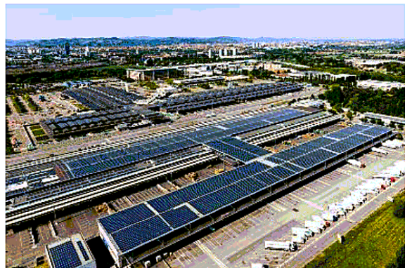
Il grande impianto fotovoltaico del Caab di via Canali
