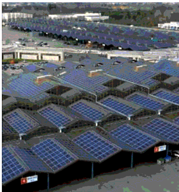
Impianti fotovoltaici al Caab, nell'ambito del progetto 'Geco'
