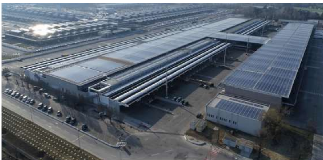
Sul capannone in basso a sinistra la nuova area di copertura del complesso CAAB. Sullo sfondo, in alto a sinistra, il tetto di Fico Eatly World
