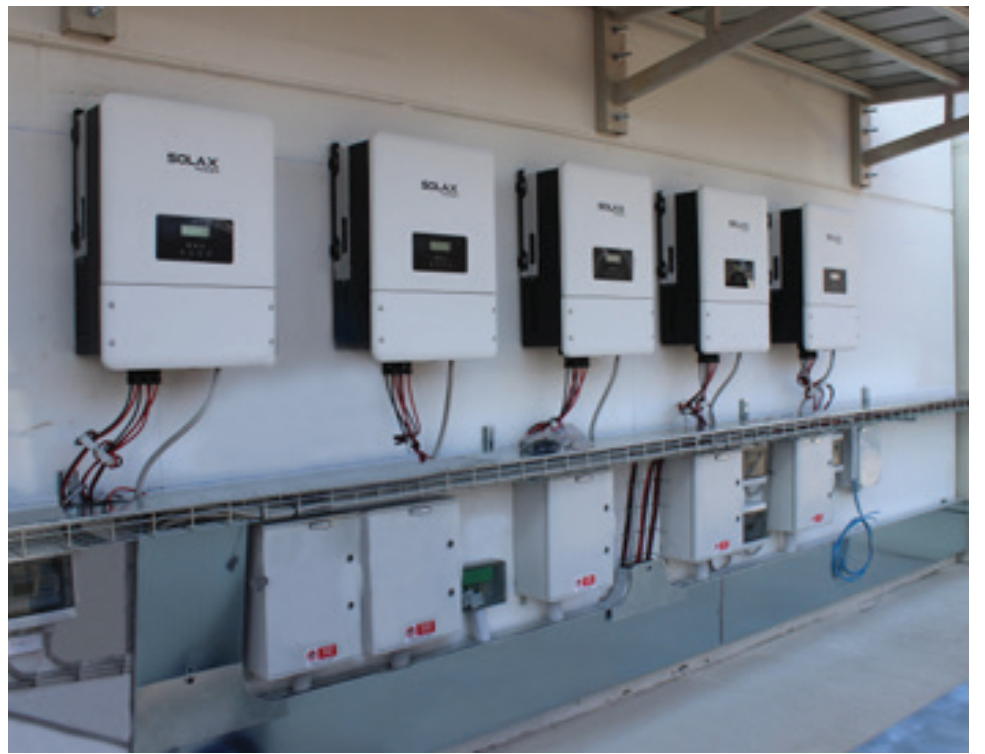
L'IMPIANTO FOTOVOLTAICO È COSTITUITO DA 1.606 MODULI POLICRISTALLINI SUNTECH DA 280 WP COLLEGATI A QUATTRO INVERTER TRIFASE ABB PVS-100-TL E A CINQUE INVERTER IBRIDI SOLAX POWER DA 10 KW
