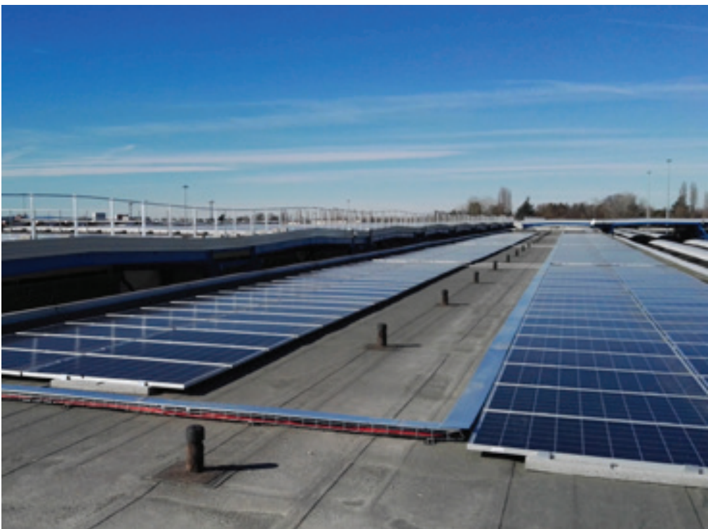
L'IMPIANTO FOTOVOLTAICO È COSTITUITO DA 1.606 MODULI POLICRISTALLINI SUNTECH DA 280 WP COLLEGATI A QUATTRO INVERTER TRIFASE ABB PVS-100-TL E A CINQUE INVERTER IBRIDI SOLAX POWER DA 10 KW
