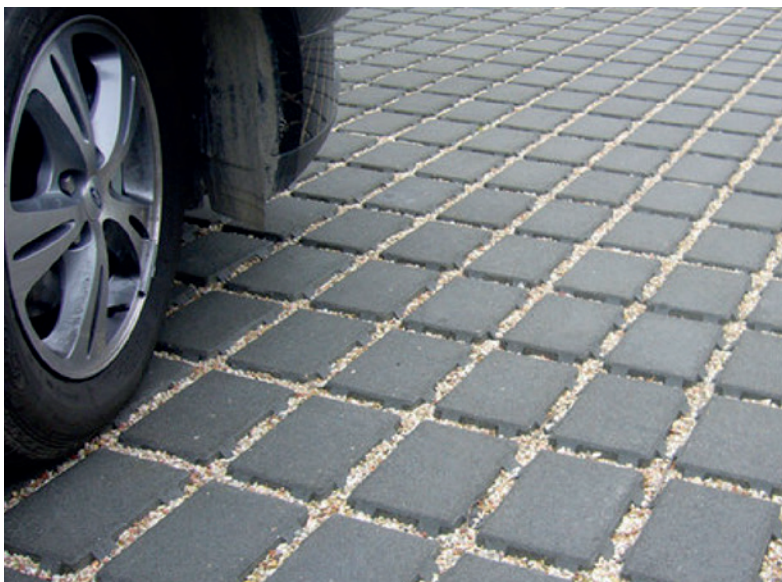
Permeabilizzazione del terreno in un'area parcheggio. Permeabilization of a public parking area.
