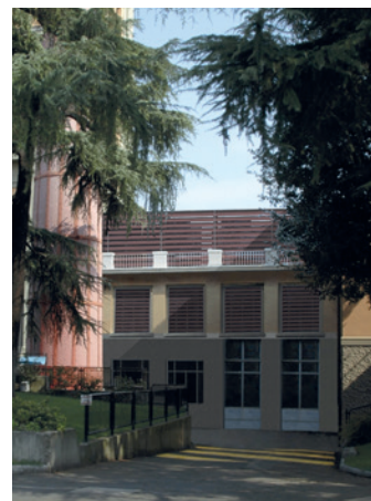
Foto dell'intervento di copertura delle tubature nell'Ospedale Sant'Orsola (prima e dopo). Pictures of the covering intervention of the heating pipes at the Sant'Orsola Hospital (before and after).
