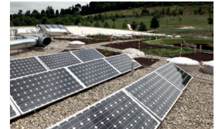
Pannelli solari sul tetto dell'asilo nido Gaia.
