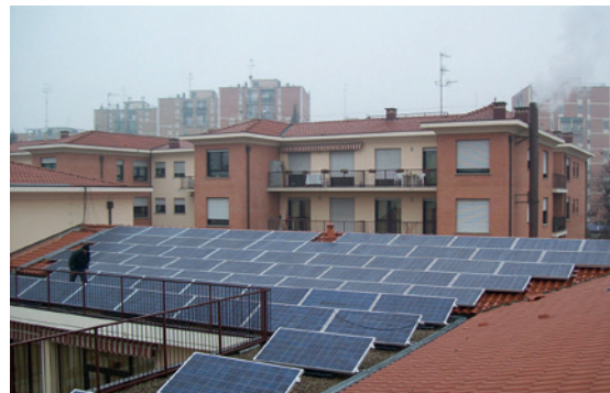
Pannelli solari sul tetto di uno degli edifici ASP.
