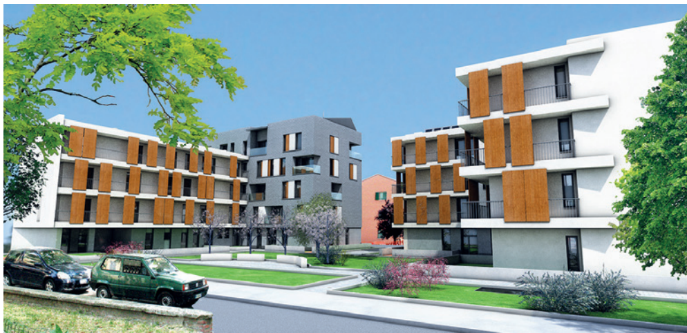
Edifici residenziali di via Beroaldo oggetto di ristrutturazione edilizia grazie ai Contratti di Quartiere. Studio TECO+ Partners. Residential buildings located in via Beroaldo and subject to building refurbishment thanks to the Neighborhood Contracts.
