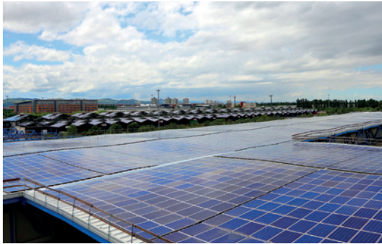
Foto dell'impianto fotovoltaico sul tetto del CAAB. Picture of the solar plant on the CAAB's rooftop.
