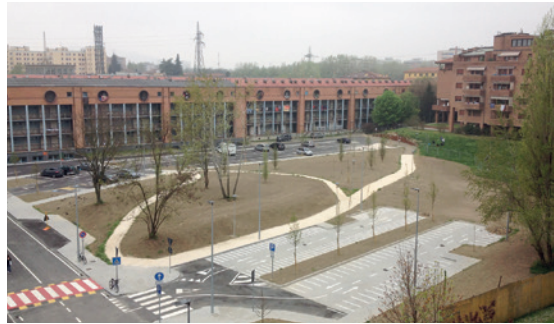
Area pedonale antistante il polo universitario del Navile. Pedestrian area beside the new University area.
