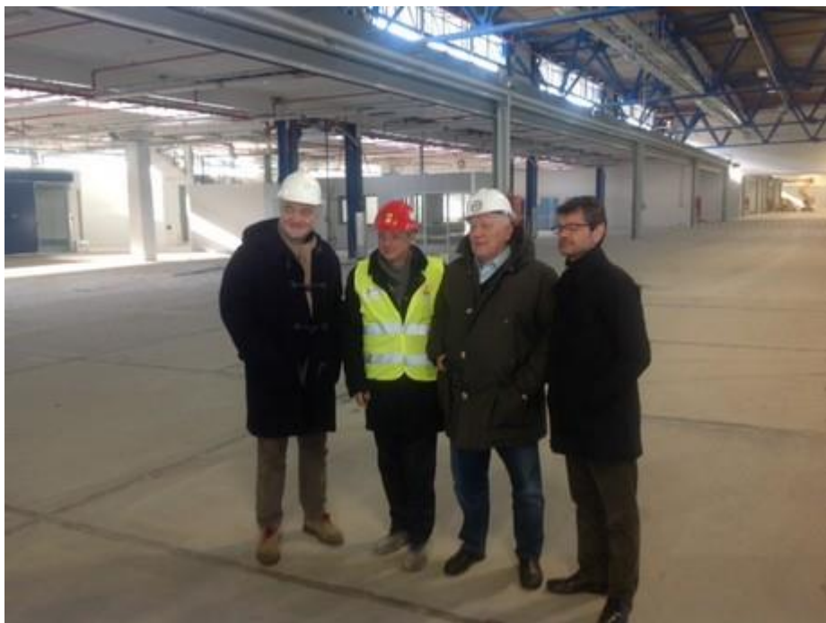
Un recente sopralluogo al NAM - Nuova Area Mercatale in costruzione.
